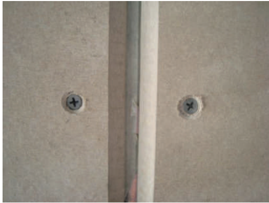
1.- Tornillos de 1¼" @ 20 cm insertando 2 mm para resane
