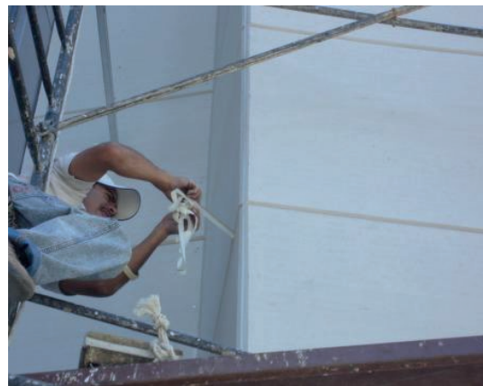
5. Retiro de cinta
