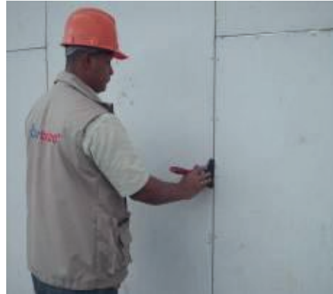
2.- Limpieza de junta
