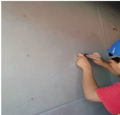
3.- Resane con "OK Resanador" de COMEX mezclado con polvo de Cempanel
