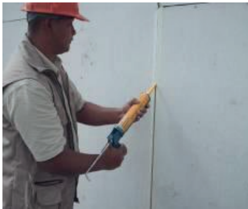
4. Aplicación de cordón de poliuretano
