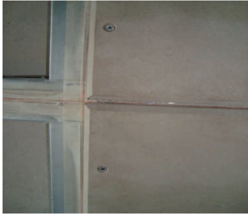
1.- Colocación previa de cinta de papel
